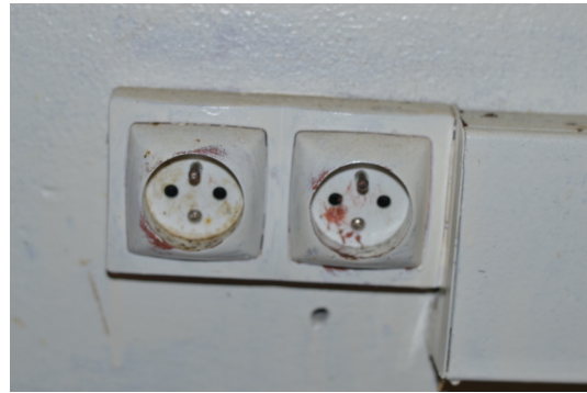
prises électriques repeintes
