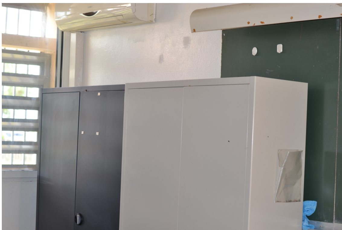
armoires métalliques situées devant le tableau faute de place
